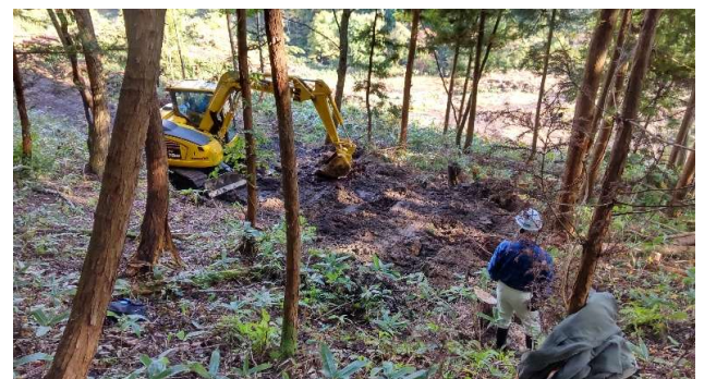
横断排水溝の設置
