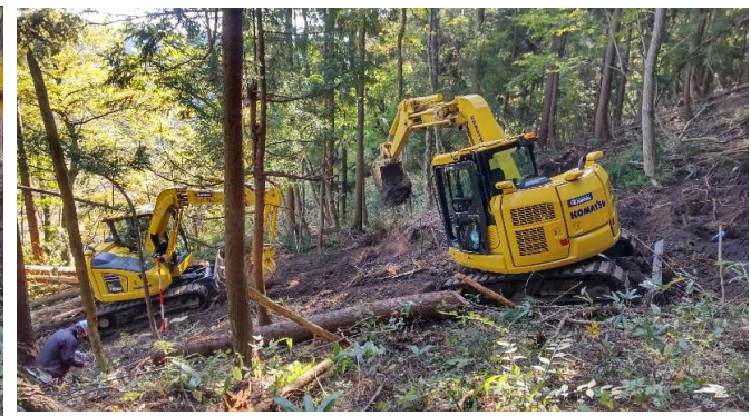
横断排水溝の設置
