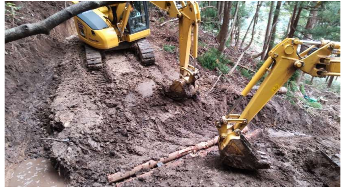
横断排水溝の設置
