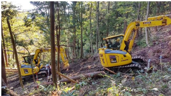
ヘアピンカーブの施工
