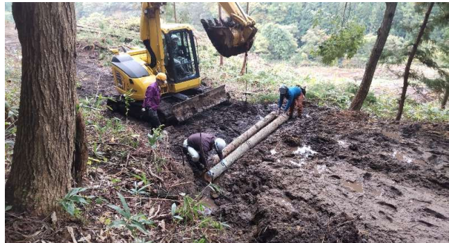
横断排水溝の設置
